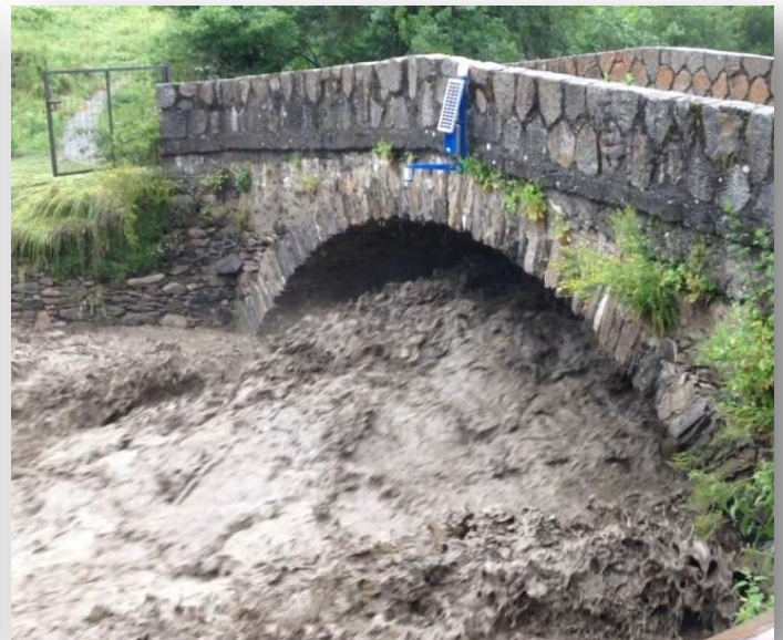
Estación de Sensores SmartyRiver400 sobre el puente de Escunhau en el momento de de la avenida.
