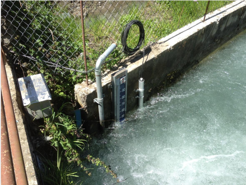
Sonda de presión en tubo tranquilizador
